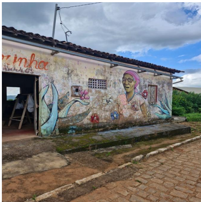
Figura 13 – Casa de farinha (Vista externa)
