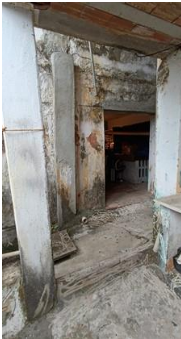
Figura 6 - Entrada do porão do Colégio Santo Antônio (CSA). 16
