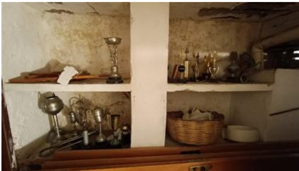
Figura 7 - Parte interna do porão do Colégio Santo Antônio (CSA). 17
