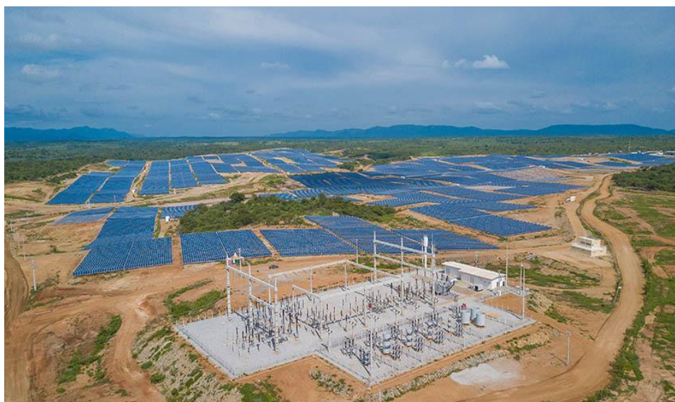
Figura 24 - Vista aérea do complexo solar de Coremas – PB
