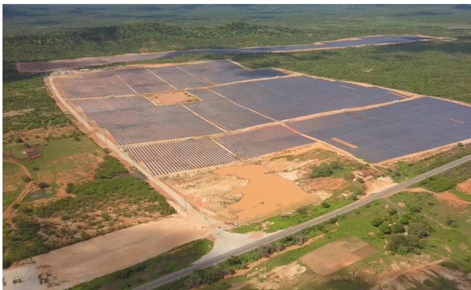
Figura 23 - Vista aérea do complexo fotovoltaico de Angico e Malta – PB
