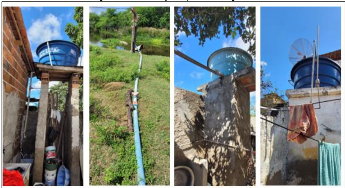
Figura 34 – Canalização superficial da água na Jurema
