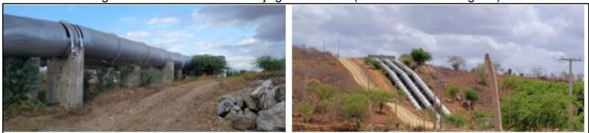
Figura 38 - Canal Acauã-Araçagi Eixo Leste (Trecho Itatuba/ Mogeiro)
