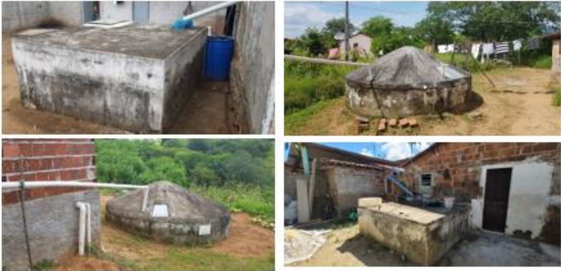
Figura 27 – Cisternas instaladas na Comunidade Jurema
