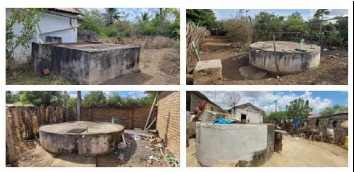
Figura 15 - Cisternas instaladas nas moradias do Juá
