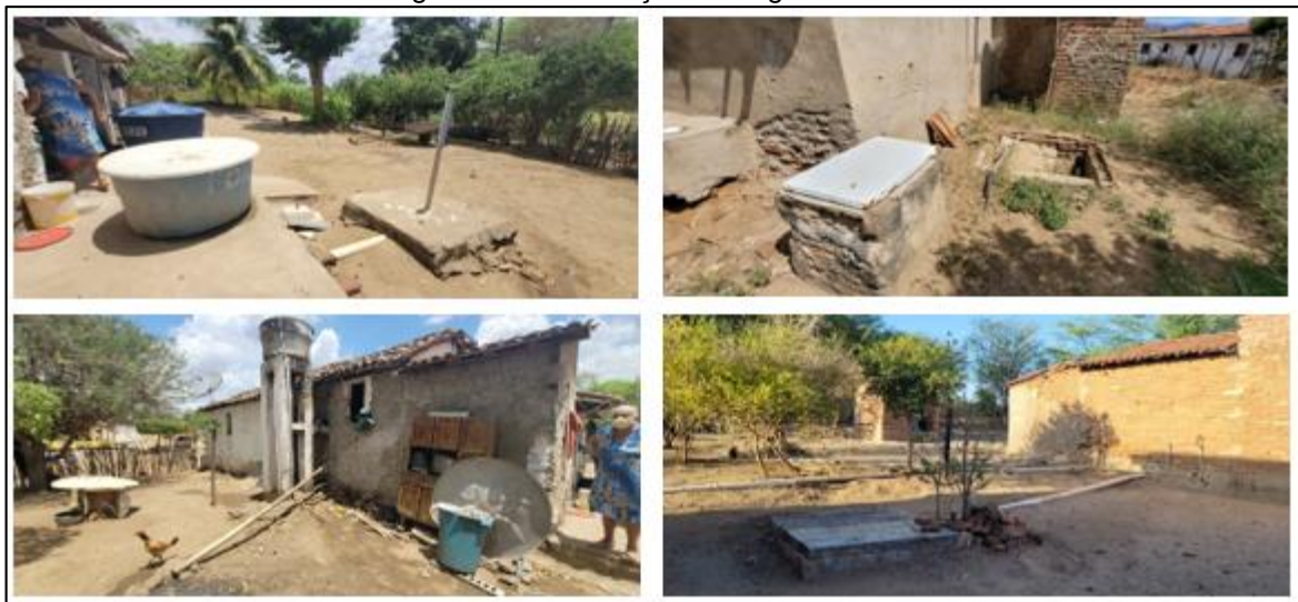
Figura 23 - Destinação do esgoto no Juá
