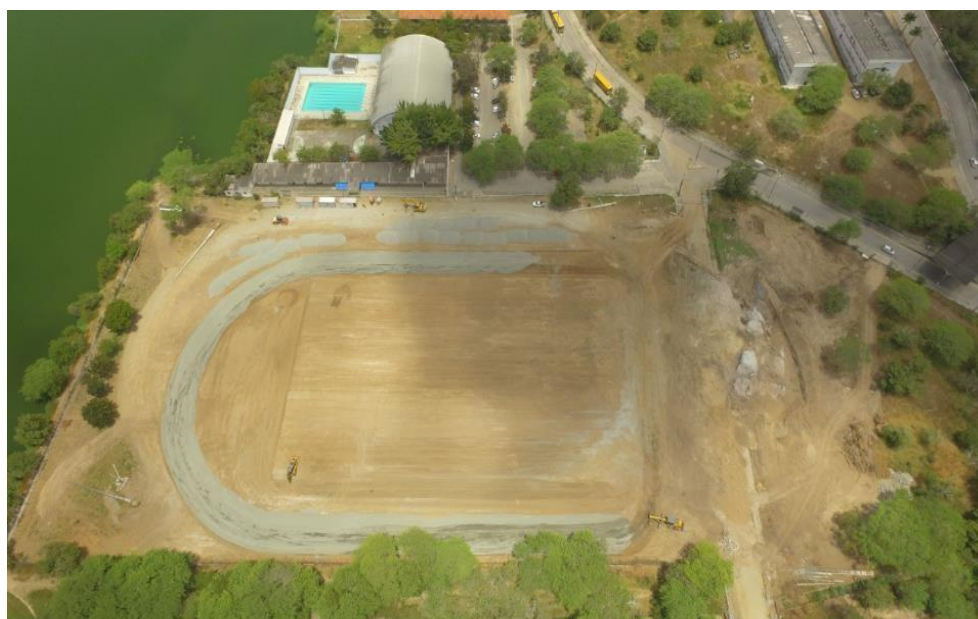
Figura 7 - Pista de atletismo em construção no Campus I – UEPB
