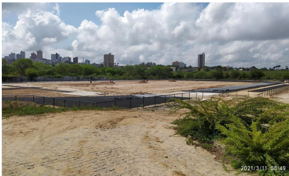
Figura 6 - Pista de atletismo em construção no Campus I - UEPB –
