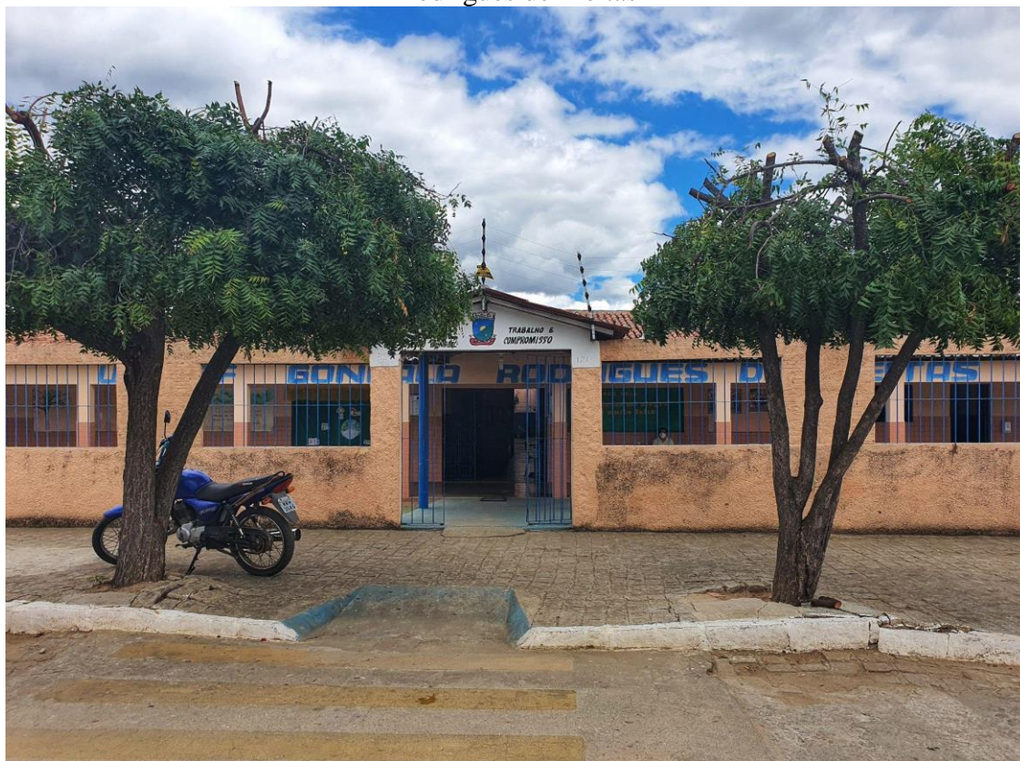
Figura 2: Fachada da Escola Municipal de Ensino Fundamental Gonçalves Rodrigues de Freitas
