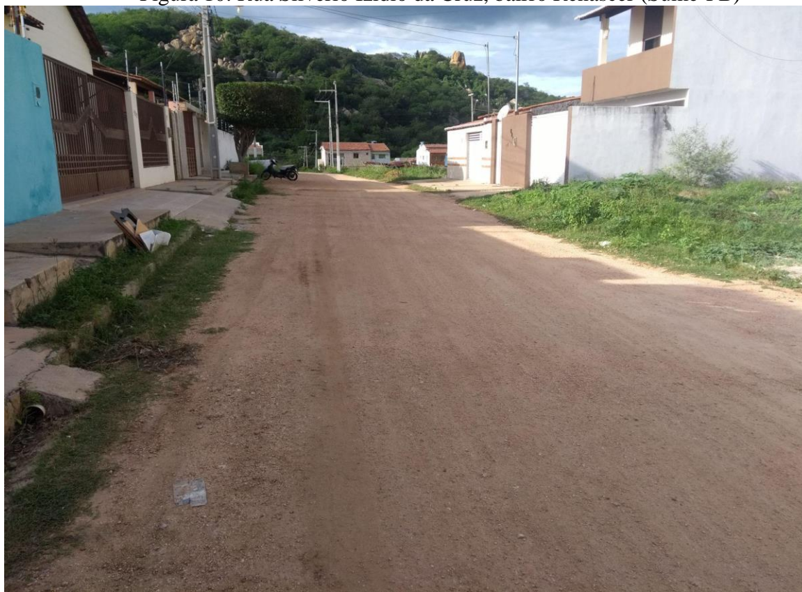
Figura 10: Rua Silvério Izidio da Cruz, bairro Renascer (Sumé-PB)
