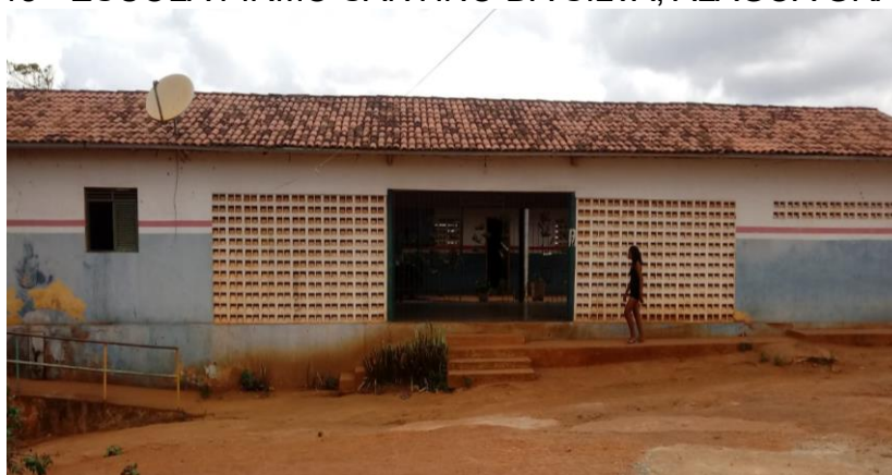
FIGURA 18 - ESCOLA FIRMO SANTINO DA SILVA, ALAGOA GRANDE - PB
