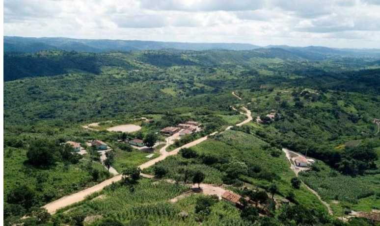
FIGURA 6 - VISTA AÉREA DA ESTRADA QUE DÁ ACESSO À COMUNIDADE CAIANA DOS CRIoulos – ALAGOA GRANDE-PB
