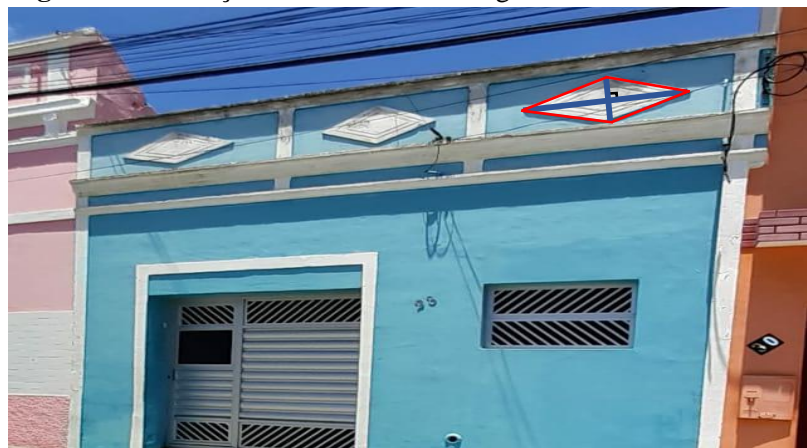
Figura 3: Edificação na Rua Getúlio Vargas
