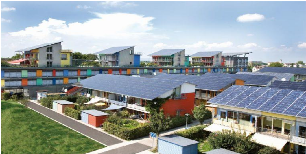
Figura 26. Vista aérea dos painéis fotovoltaicos na cidade de Vila Solar em Friburgo, Alemanha.
