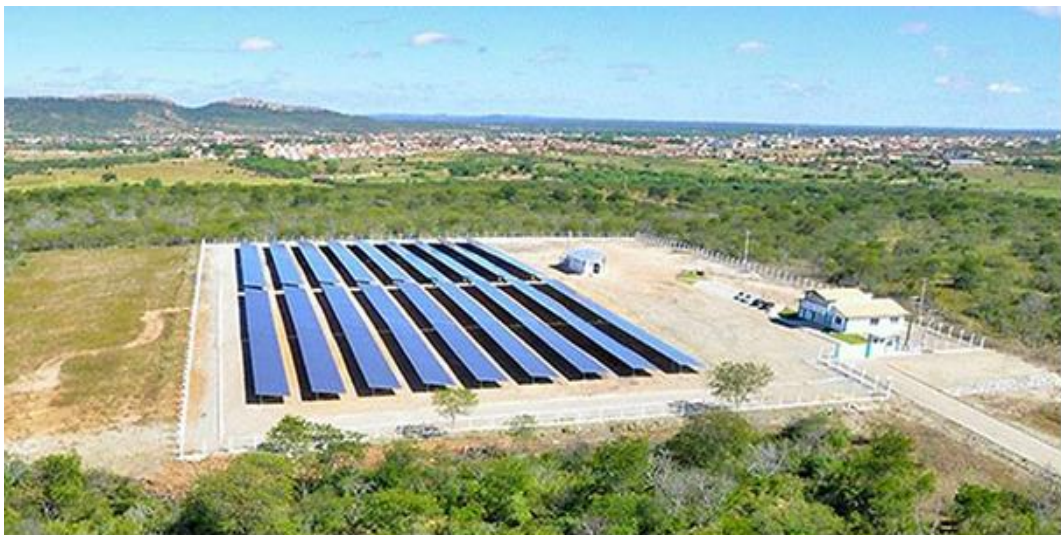
Figura 33 Vista aérea da usina fotovoltaica de Tauá, CE.
