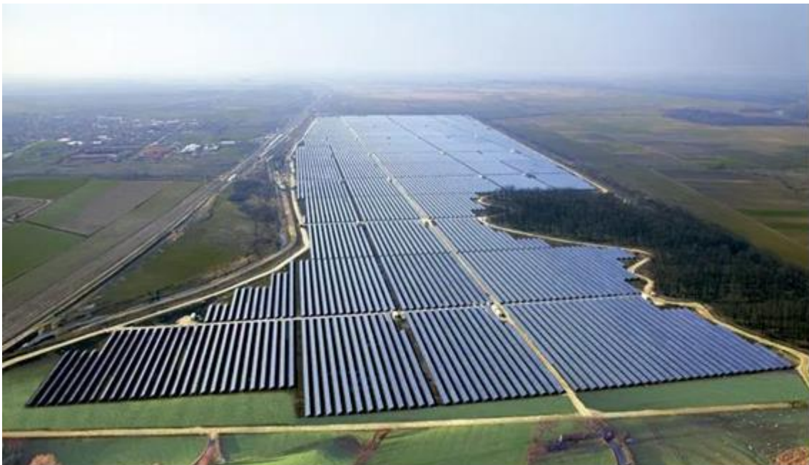
Figura 8. Vista da maior usina solar da América Latina, o complexo fotovoltaico de Ituverava, Bahia.
