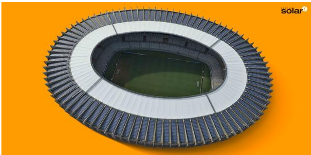
Figura 34. Vista da usina solar fotovoltaica do estádio Mineirão, Belo Horizonte, MG.
