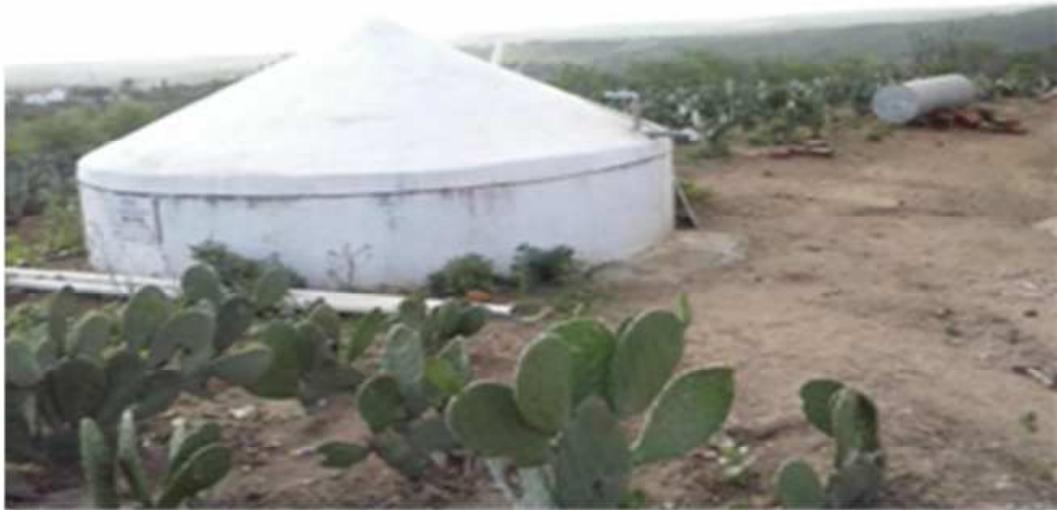
A cisterna de placas fica enterrada no solo até mais ou menos dois terços da sua altura e consiste de placas de concreto (mistura cimento: areia de 1: 4), com tamanho de 50 por 60 cm e 3 cm de espessura, curvada de acordo com o raio projetado da parede.
