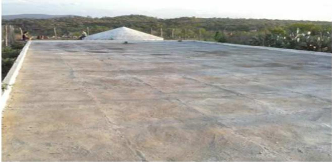
A tecnologia do calçadão (Figura 15) é um modelo que permite não somente a captação da água da chuva, mas, o de utilizar o calçadão para secagem de grãos, tais como: feijão e milho, raspa de mandioca, dentre outros. A cisterna de placa com um volume de 52 m<sup>3</sup> destina-se, prioritariamente, para o uso da água nas atividades da pequena produção familiar e dessedentação animal.
