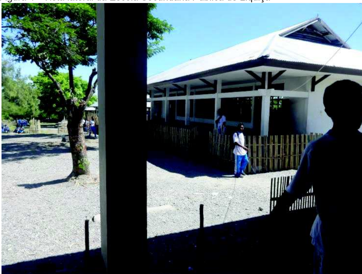
Figura 4 - Vista lateral da Escola Secundária Pública de Liquiçá
