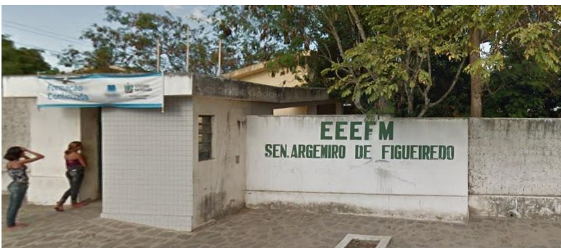
Figura 13: Frente da E.E.E.F.M. Senador Argemiro de Figueiredo Fonte: retirada do Google maps
