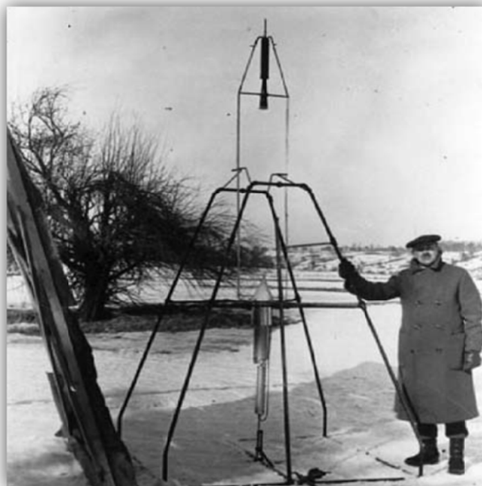
Figura 1 – Goddard e o primeiro foguete movido a combustível líquido que alcançou 46 metros de altura
