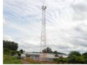
( ) Antenas de telefonia móvel
