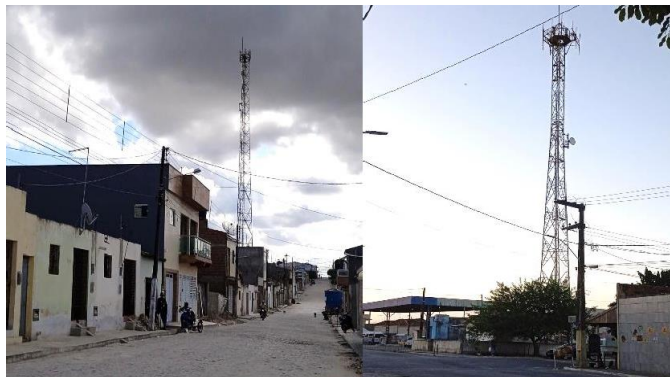
Figura 11 – Antenas de telefonia móvel localizadas em Areial/PB
