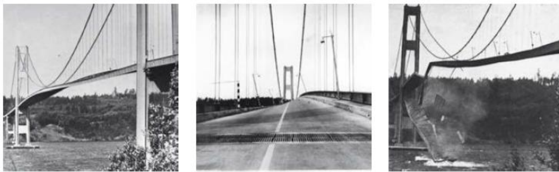
Figura 3 – Ponte de Tacoma Narrows (1940): destruída por ressonância
