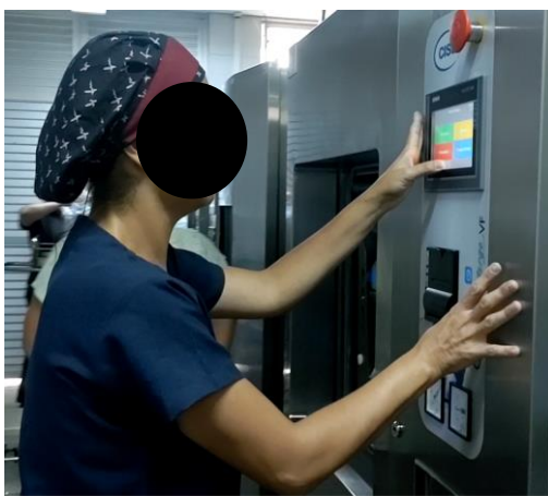
Figura 13 - Posicionamento adequado do painel de controle de uma autoclave na CME do hospital de emergência e trauma, Campina Grande, PB, 2024.
