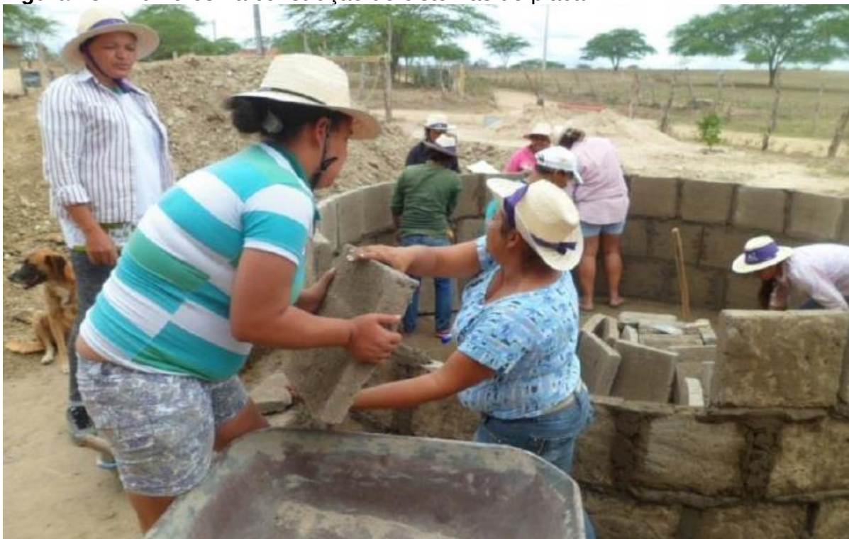
Figura 18 - Mulheres na construção de cisternas de placa
