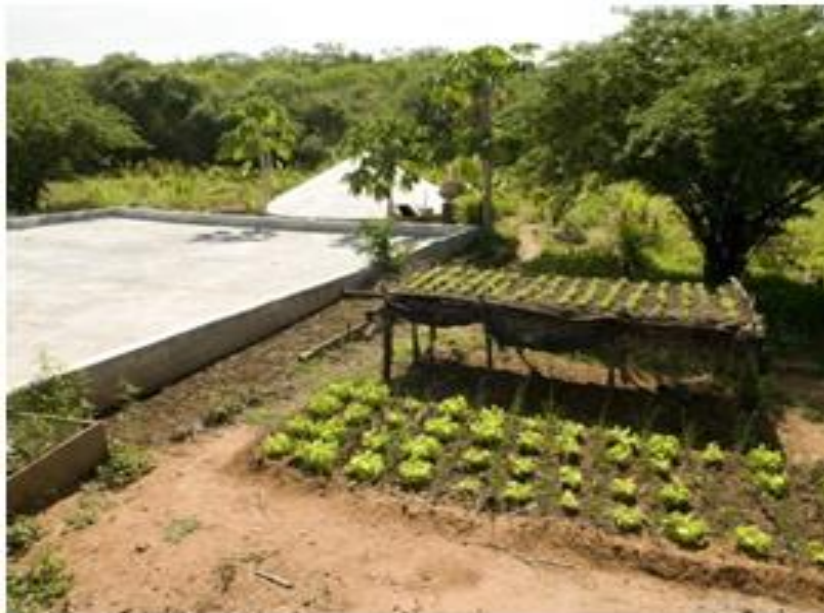
Figura 8 - Cisterna calçadão para benefício de plantações
