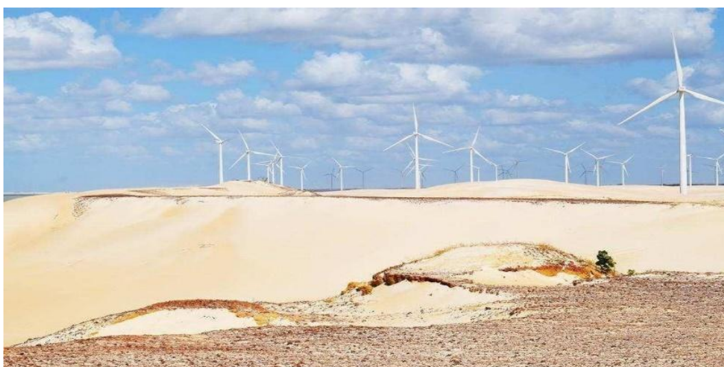
Figura 4. Vista aérea do parque eólico em Galinhos- RN
