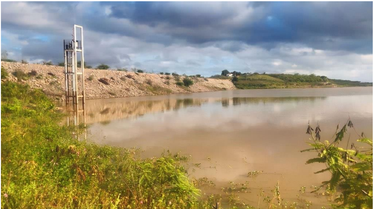
Reservatório Barra do Juá, bacia hidrográfica do Rio Pajeú, estado de Pernambuco, Nordeste de Brasil. Fonte: Própria
