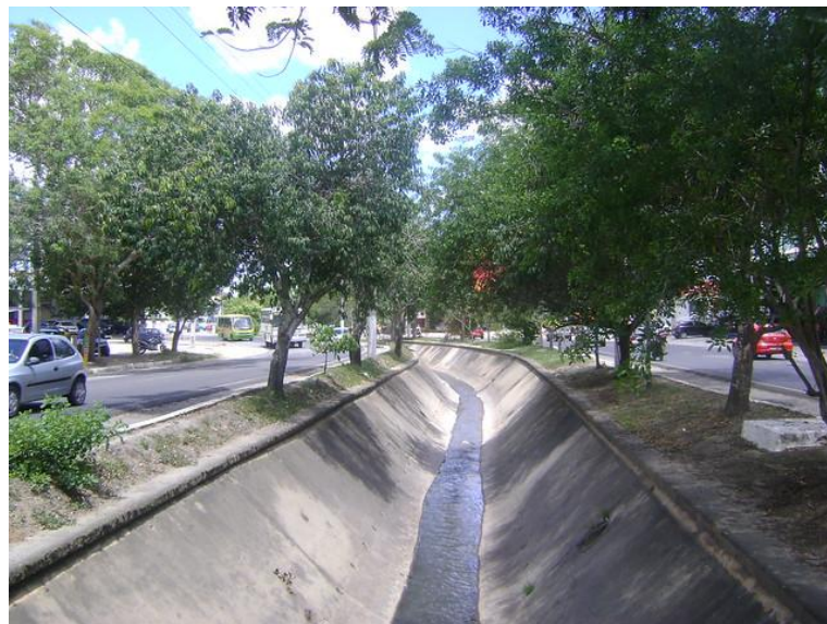
Figura 2 - Avenida Canal em Campina Grande
