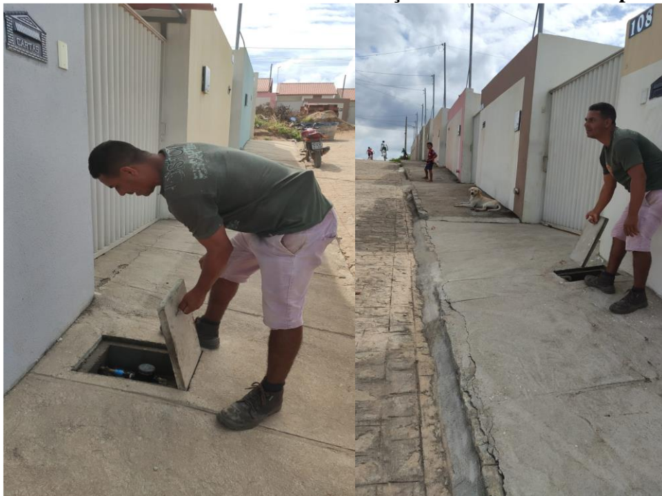
Figura 10 – Casas do novo loteamento com instalações hidráulicas feitas e padronizadas
