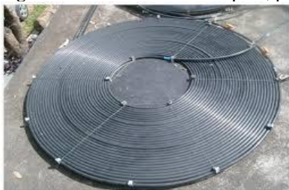
Figura 19: Coletor solar em espiral, plano e tubular para aquecimento de água
