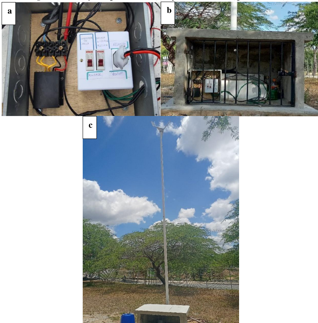
Figura 32: Instalação do gerador eólico(a) suporte de alvenaria(b)gerador eólico(c)
