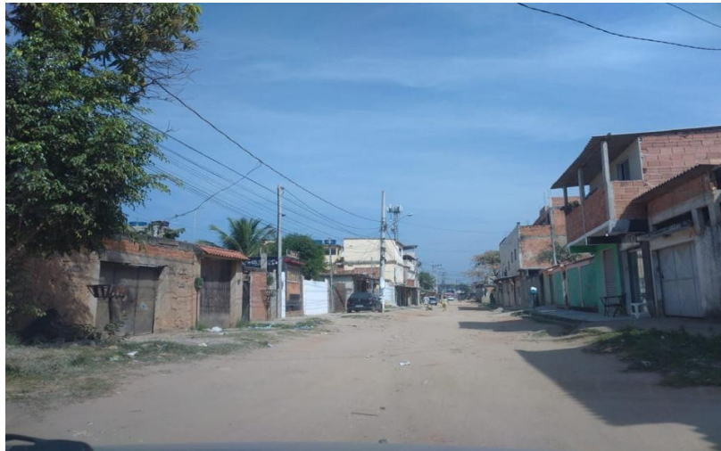
Figura 9: Vista da Rua Dom Aquino Correia, nº. 185- Bairro Guaratiba - Município de Santa Cruz/RJ
