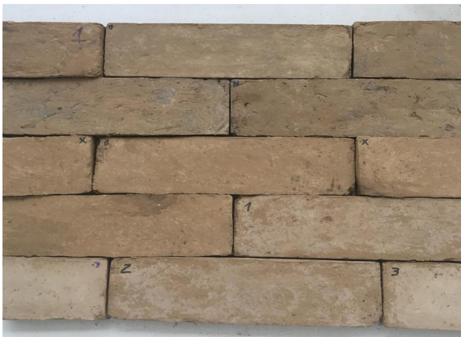
Figura 23: Compósitos Aplicados à Parede sem Tratamento na Superfície.
