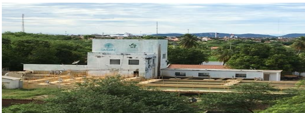
Figura 06 - Estação de Tratamento de Água (ETA) Patos/PB.
