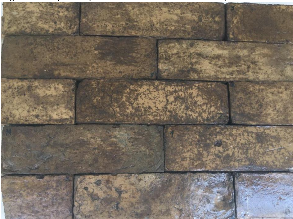
Figura 24: Compósitos Aplicados à Parede com Tratamento na Superfície.
