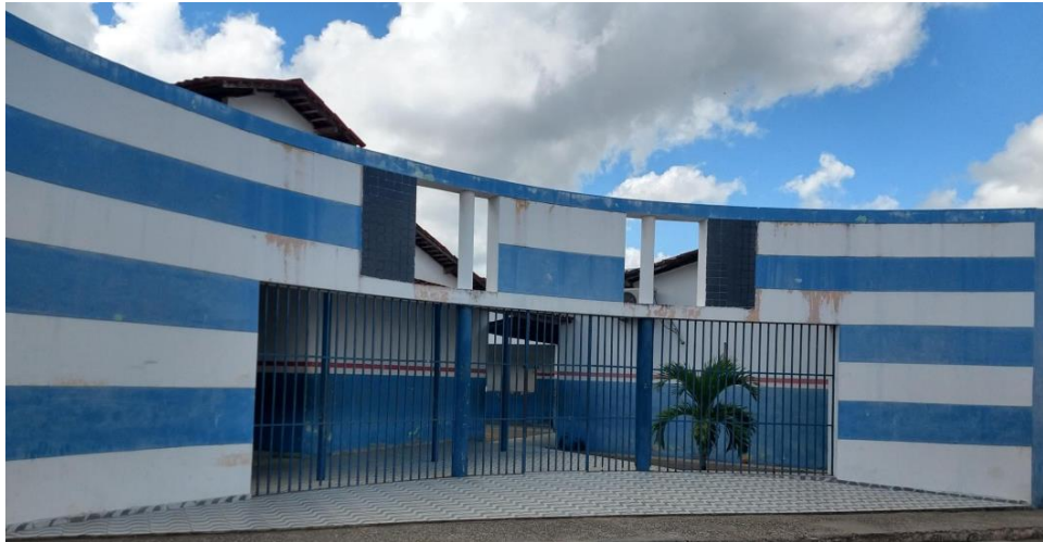
Figura 11 - Fachada da Escola Cândido Régis de Brito Fonte: Acervo escolar/2019
