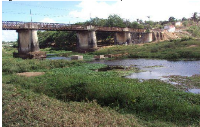
Figura 1 – Ponte metálica e o Rio Capibaribe – Paudalho – PE
