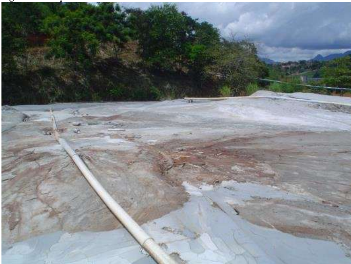
Figura 17 – Depósito de lama abrasiva.
