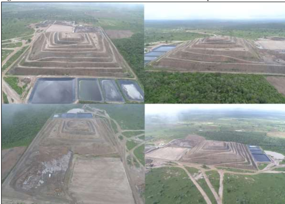
Figura 4 – Vista aérea da macro célula do Aterro Sanitário em Campina Grande.
