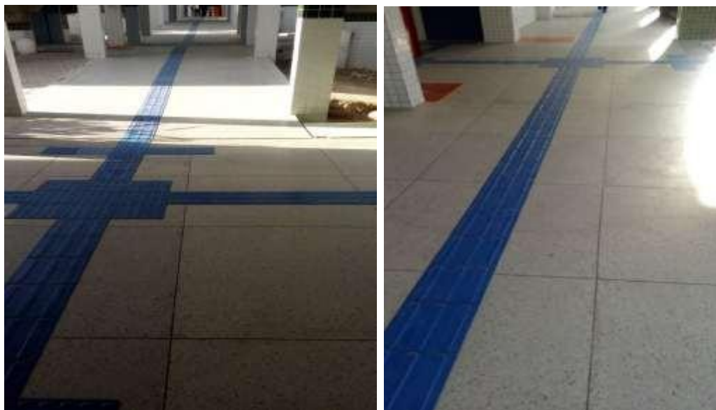
Figura 5: Piso tátil nos corredores da instituição
