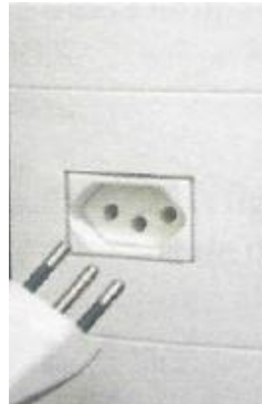
Figura 5051: Tomada elétrica de 127V ou de 220V
