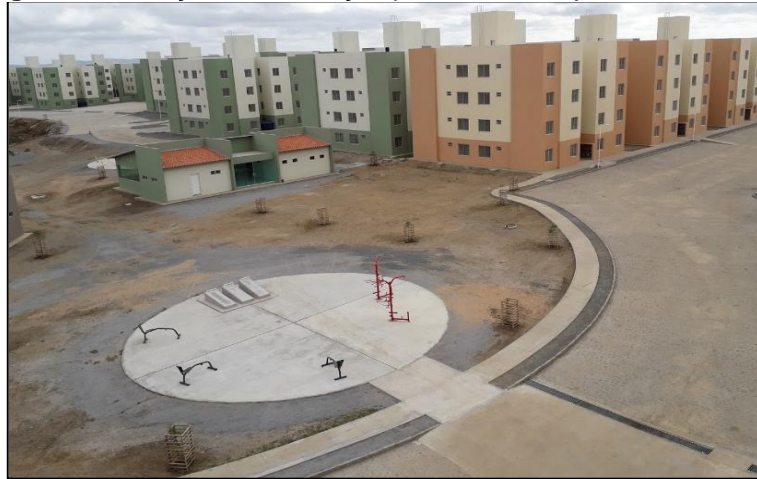
Figura 18 – Praça em construção próxima ao conjunto de edifícios.
