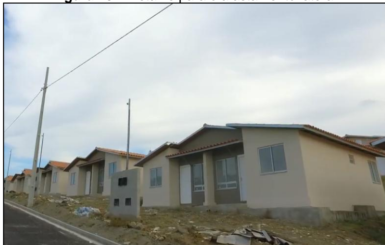
Figura 10 – Detalhe para o afastamento lateral.
