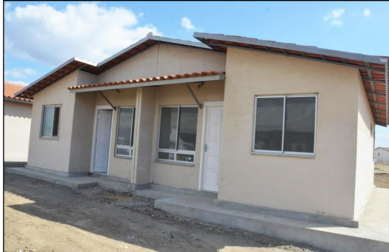
Figura 8 – Casas do conjunto habitacional do CMAC finalizadas (visão frontal).
