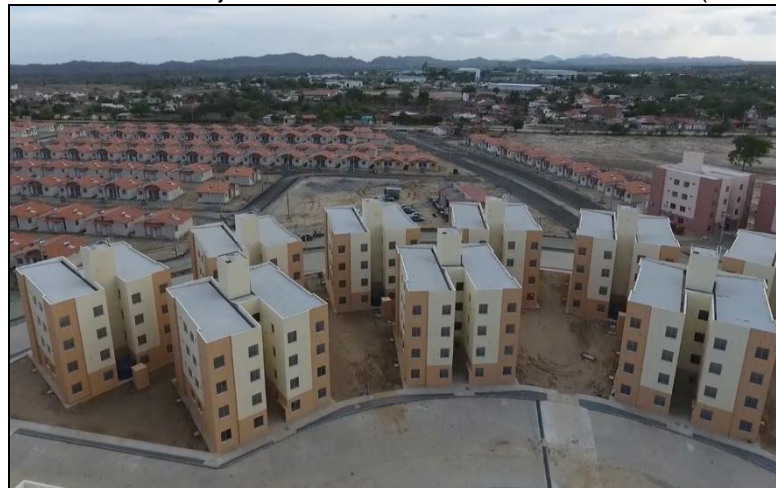
Figura 13 – Parte do conjunto de edifícios residenciais do CMAC (visão inferior).
