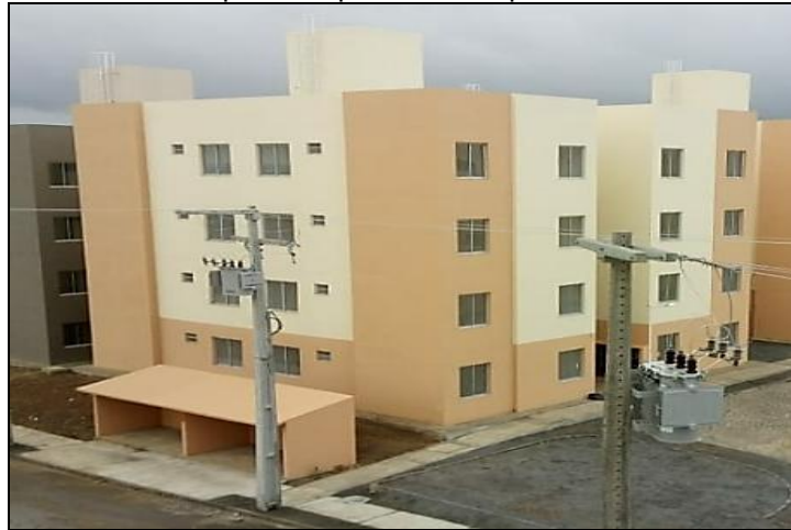
Figura 12 – Imagem em perspectiva de um dos edifícios do CMAC que comporta 4 apartamentos por andar.
