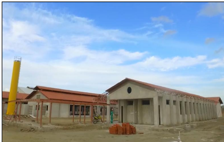
Figura 20 – Imagem em perspectiva de uma das escolas (ainda em construção).
