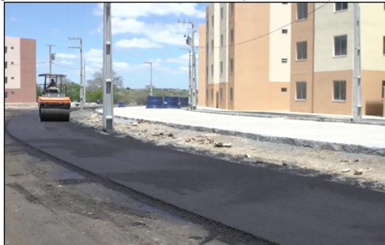
Figura 17 – Rua/avenida sendo asfaltada próxima aos apartamentos.
