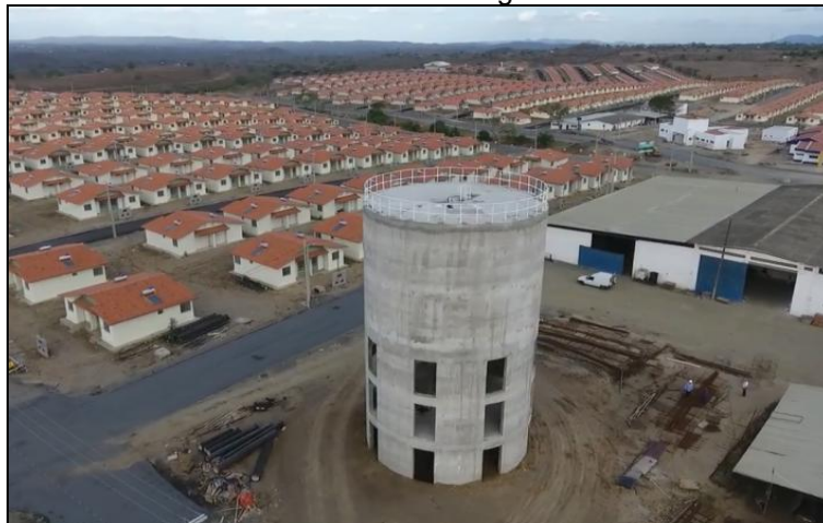
Figura 22 – Ruas e casas do conjunto habitacional com a adutora de água ao centro da imagem.
