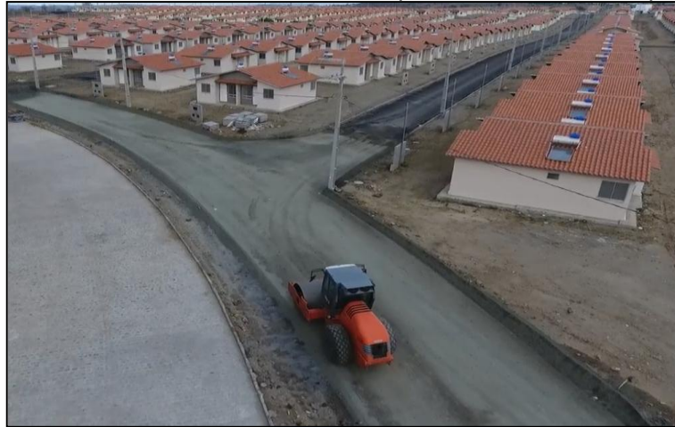
Figura 16 – Rua/avenida sendo asfaltada próxima à entrada das quadras.
