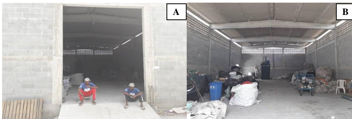
Figura 36. (A) e (B) Galpão da ARENSA construído recentemente.
