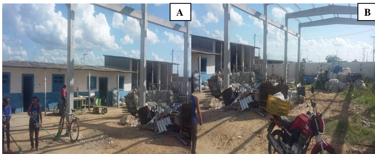
Figura 17. (A e B) Exposição à radiação solar por falta de estrutura da sede da associação. Fonte: Próprio autor
