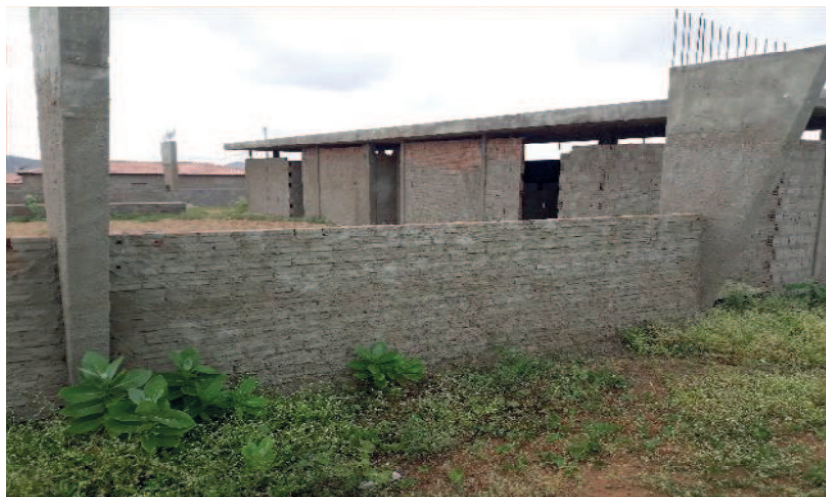
Figura 3: Construção do ginásio.
