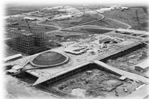
Início da construção do Palácio do Planalto
