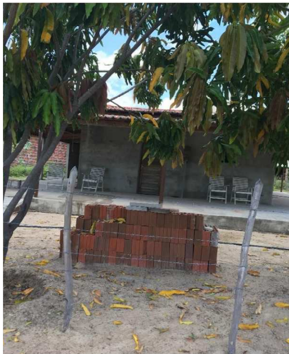
FIGURA 11 – CONSTRUÇÃO DE CASAS
