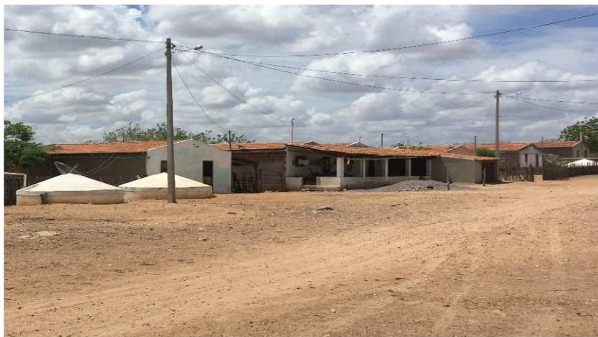
FIGURA 7 – CISTERNAS DE 16.000 LITROS NAS RESIDÊNCIAS EM FIRMEZA
