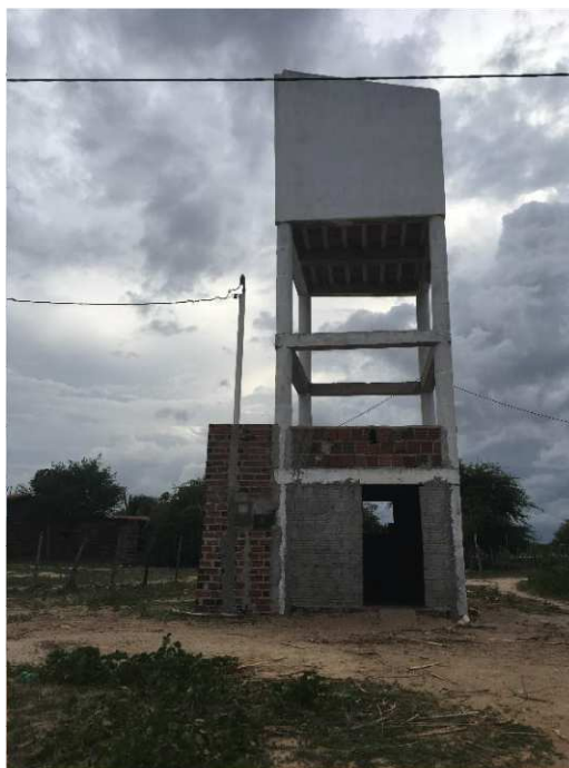
FIGURA 17 – CAIXA D'ÁGUA DA ASSOCIAÇÃO
