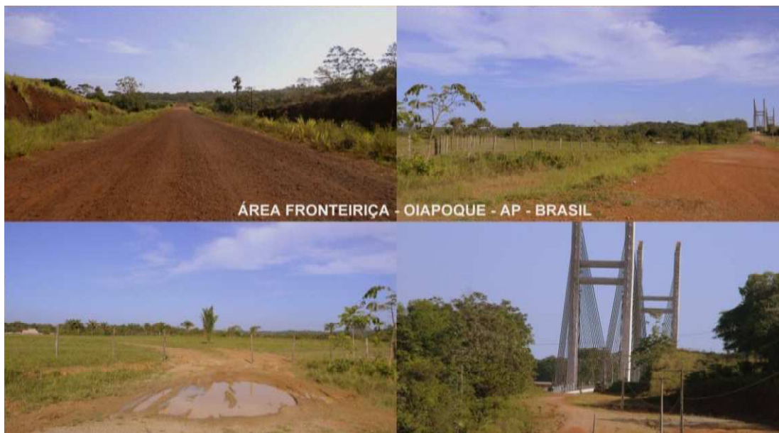
Fotografia 2 - Área de Acesso à Ponte pelo lado brasileiro. Fonte: Do autor (2012).
