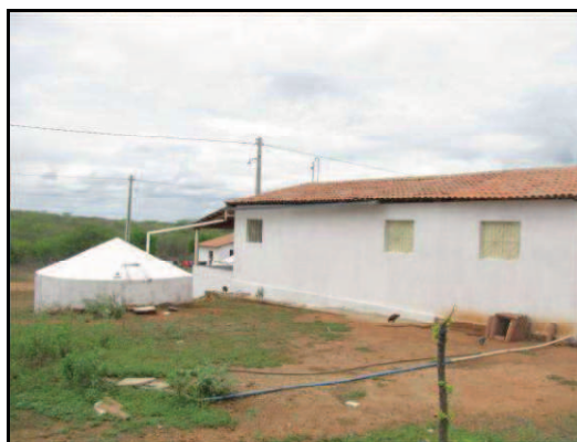
Figura 16: Vista da casa e da cisterna de José dos Santos. Foto: Janeiro, 2012
