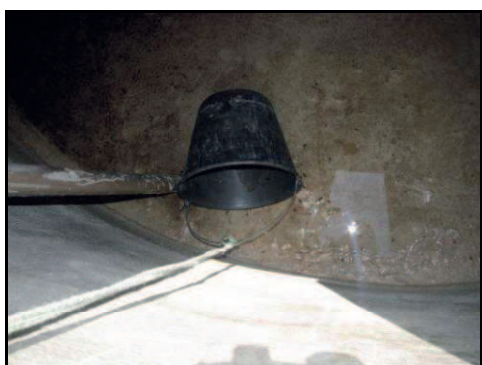
Figura 10: Balde no interior da cisterna. Foto: Janeiro, 2012
