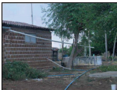
Figura 09: Fossa localizada próxima à cisterna. Foto: Janeiro, 2012
