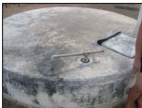
Figura 07: Bomba manual para a coleta de água da cisterna. Foto: Janeiro, 2012
