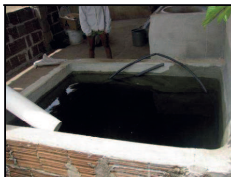
Figura 18: Reservatório construído pela família de Dona Alcilene. Foto: Janeiro, 2012
