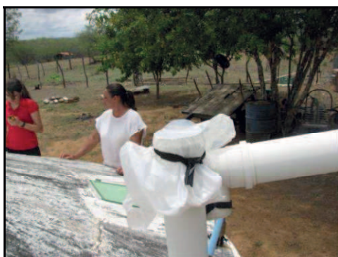
Figura 17: Sistema vedado por sacos plásticos. Foto: Janeiro, 2012
