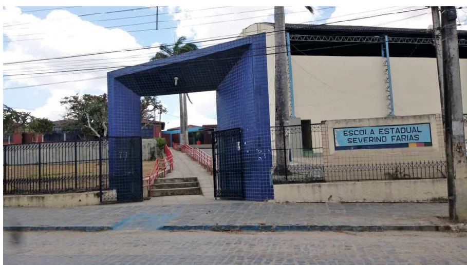
Figura 9 – Pórtico de Entrada da Escola (foto Lúcia Farias, 2017)
