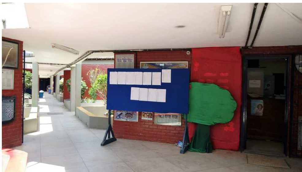
Figura 11 – Parte interna – entrada direita (Foto Lúcia Farias 2017)
