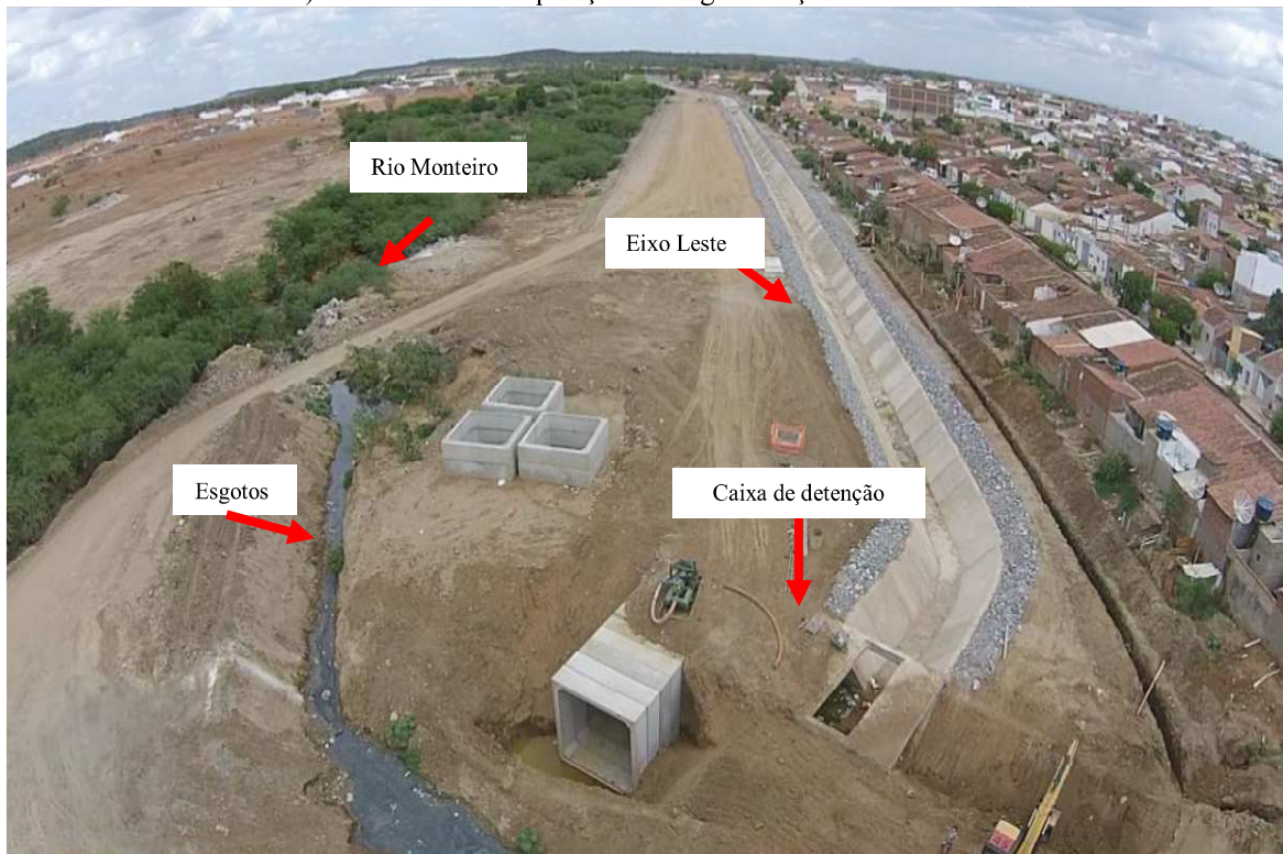
Figura 29. Vista do canal de drenagem de águas superficiais e de esgotos aos arredores da cidade de Monteiro (à direita) e o canal de Transposição e o esgoto lançado no Rio Monteiro.
