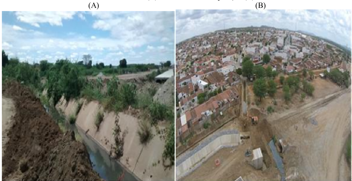
Figura 28. Vistas de uma galeria coletora de águas superficiais da cidade de Monteiro-PB, que deságua no leito do rio do Meio (A) e no canal da transposição (B).
