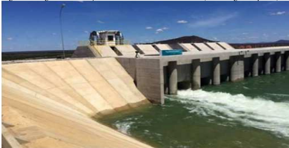
Figura 5. Imagem da 1ª Estação de Bombeamento no Eixo Leste, na barragem Itaparica, PE.
