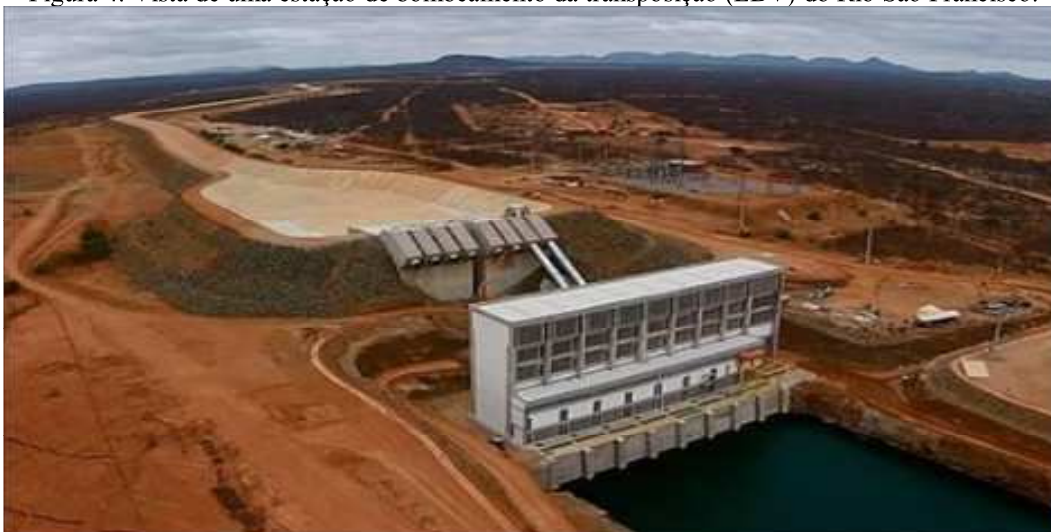
Figura 4. Vista de uma estação de bombeamento da transposição (EBV) do Rio São Francisco.
