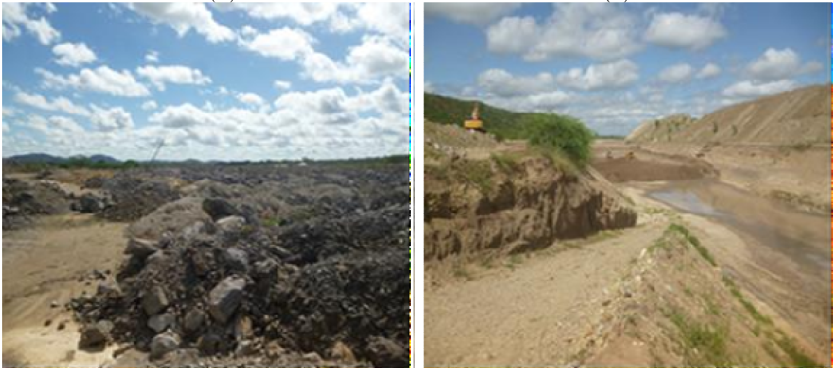
Figura 17. Vista do material retirado da escavação para construir a galeria (A) com a respectiva devolução (B). (A) (B)
