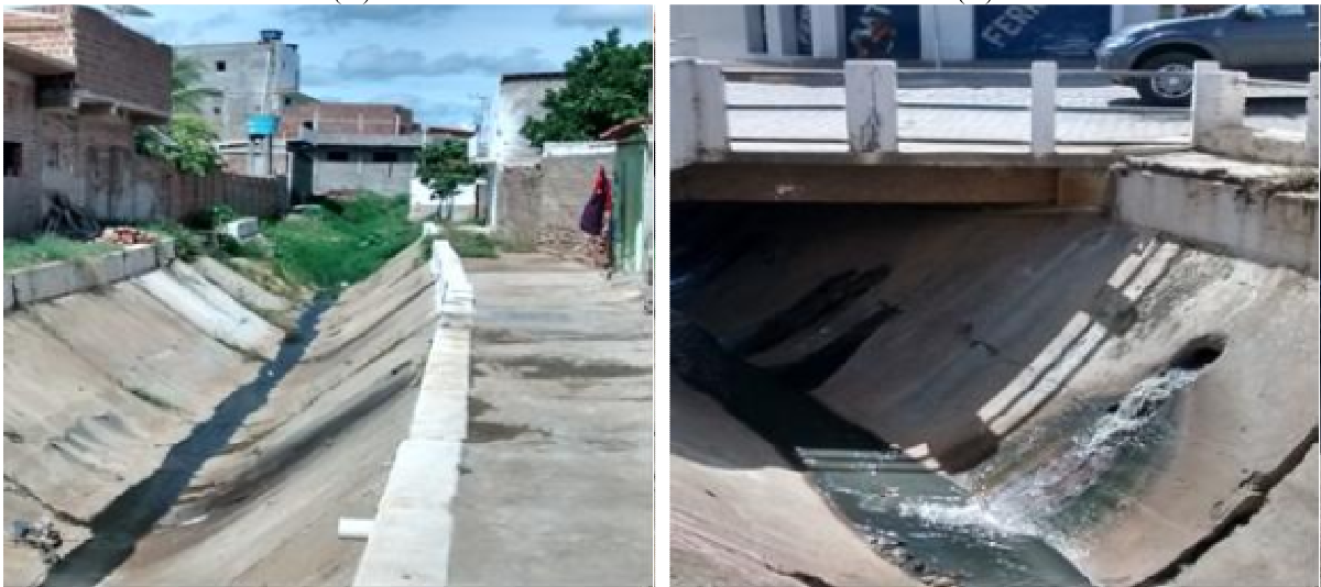
Figura 27. Vistas do canal da rede de águas superficiais (A), com a presença de esgotos (B). (A) (B)
