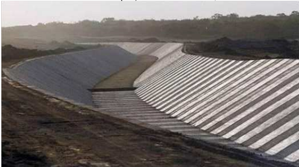
Figura 3. Vista do canal do eixo Leste de transposição do Rio São Francisco, entre Custódia-PE e Monteiro-PB.
