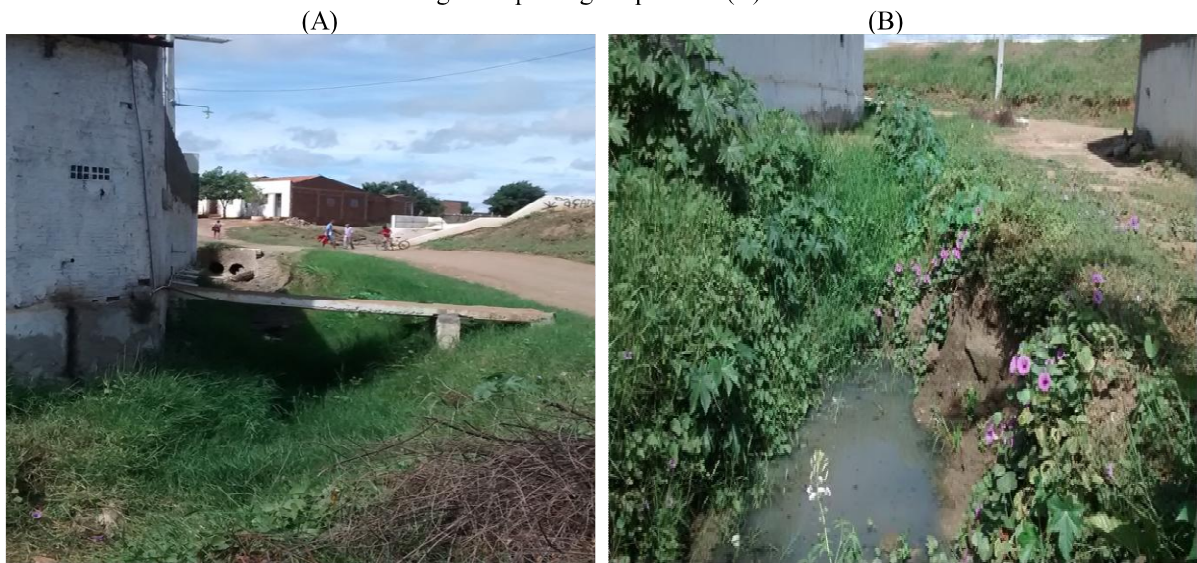
Figura 25. Detalhes do canal subsequente ao sangradouro barramento (A), e do encontro deles com o início da galeria para águas pluviais (B).
