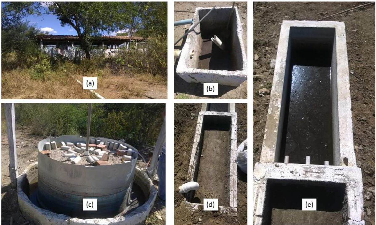
Figura 21 – Sistema de biodigestão.
