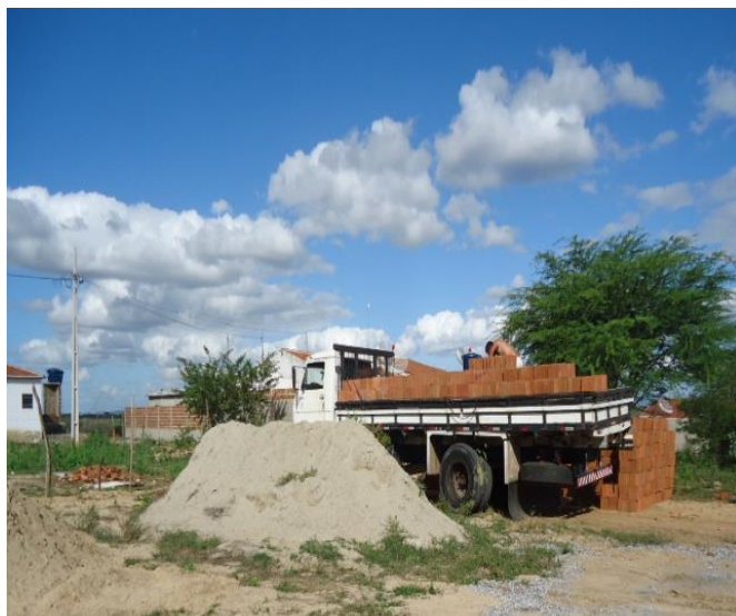
Figura 6- Início de obra
