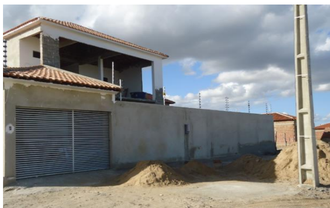
Figura 4- Obra em acabamento
