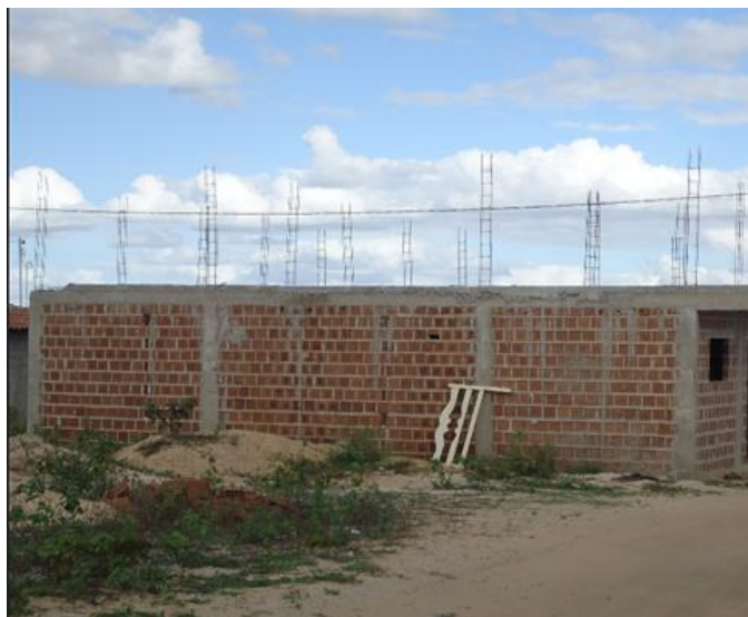
Figura 5 – Obra de 1º andar
