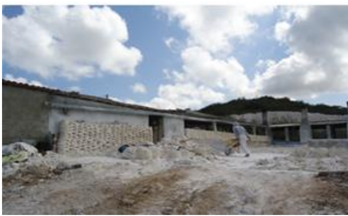
Figura 8 – Instalações industriais do caulim
