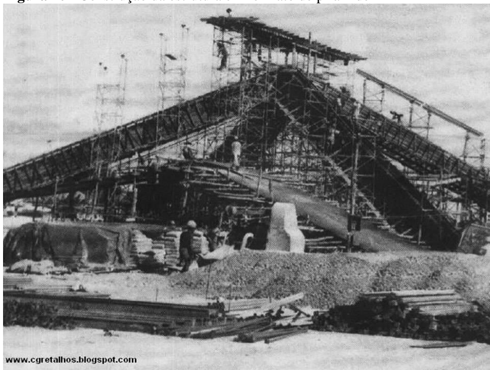
Figura 10 - Construção da estrutura em formato de pirâmide
