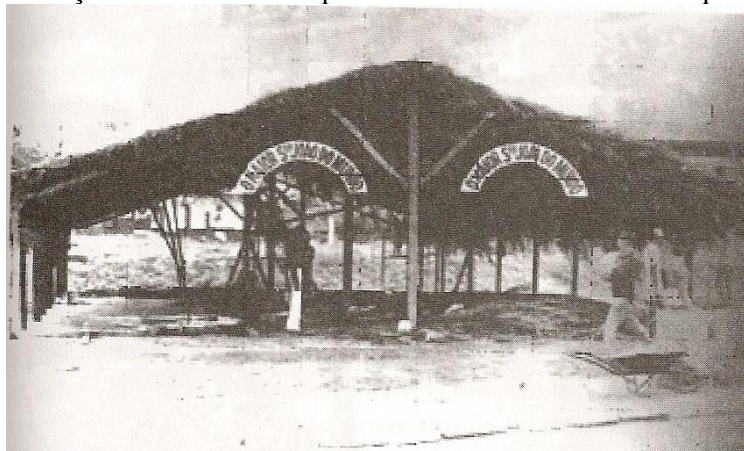
Palhoção de Campina Grande; um pequeno arraial em 1983. Fonte: Diário da Borborema/PB.
