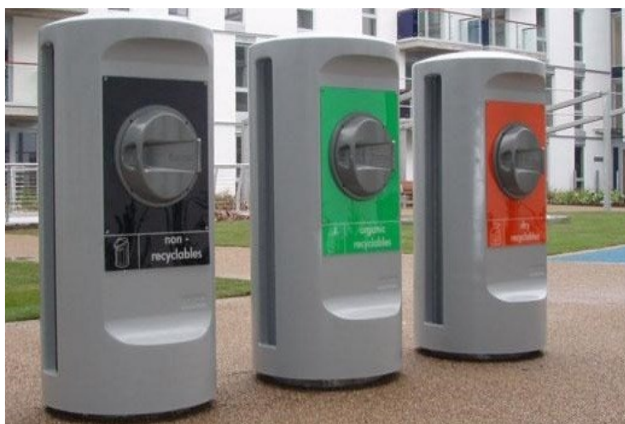
Foto 04 – Sistema de coleta seletiva com dutos subterrâneos para reciclagem na cidade de Barcelona, Espanha.
