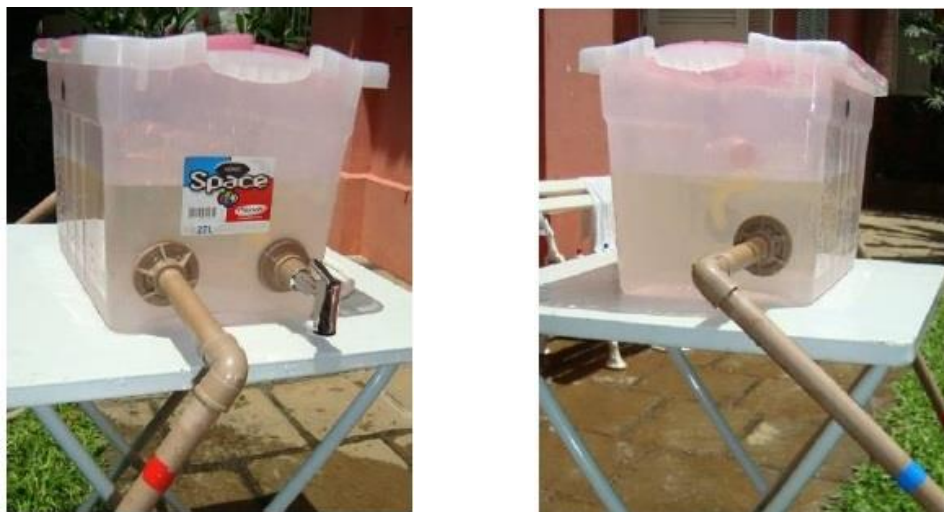
Figura 51 - Encaixes das tubulações no coletor
