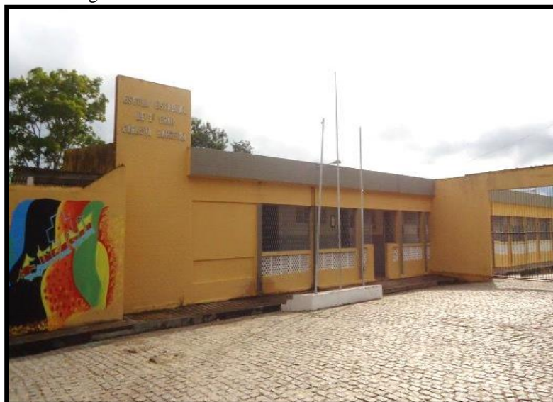
Figura 5 - Fachada da Escola Estadual Carlota Barreira
