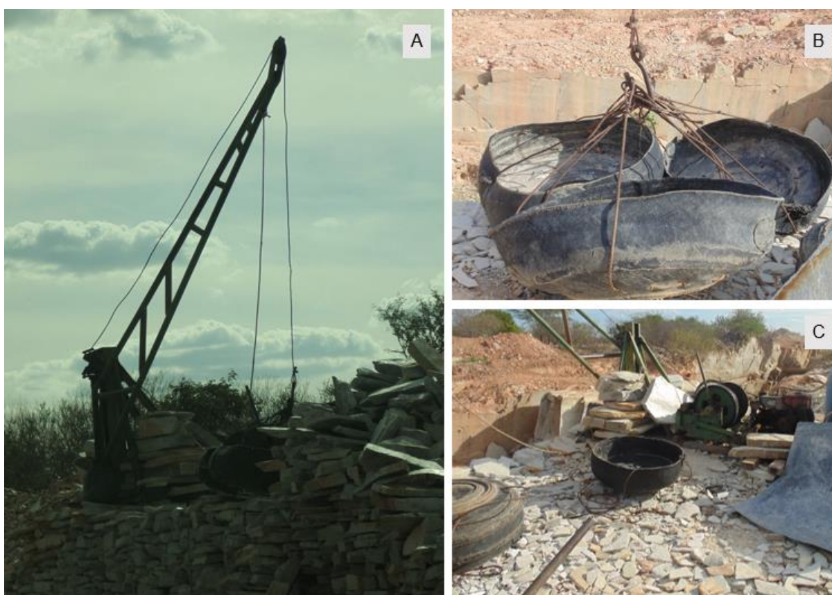
Figura 5.5 - Guincho utilizado para o transporte de materiais para dentro e fora das bancadas
