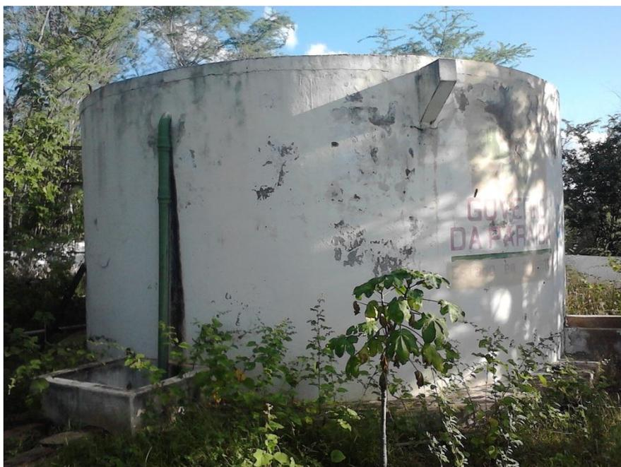
Após a adição de cloro, a água vai para o reservatório de rede, que tem capacidade para 50 m<sup>3</sup>; quando o reservatório completa seu volume máximo, os funcionários acionam a distribuição dela para a cidade.
