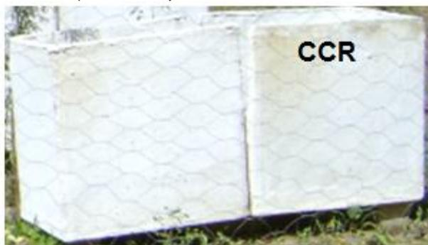
Cada compartimento foi confeccionado com uma redução de 0,25 m de altura em uma de suas paredes laterais. Essa diferença na altura de uma das paredes de cada compartimento foi projetada para proporcionar o reviramento dos resíduos através da passagem dos mesmos, de um compartimento para o outro, a cada dois dias, diminuindo o esforço físico empregado no momento do reviramento. O reviramento foi manual e aconteceu com o auxílio de ferramentas agrícolas.
