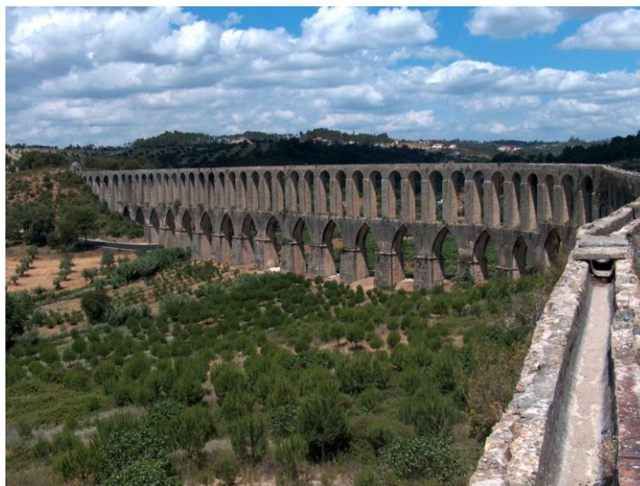
Figura 01 - O Aqueduto dos Pegões, em Tomar, Portugal. Disponível em: < http://mjfs.wordpress.com/2008/03/04/aqueduto-dos-peges-tomar/ >
