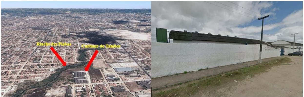
Foto 03 – Curtume do Tambor (vista aérea do Bairro do Tambor e Faixada de frente do Curtume) Fonte: Google Maps, 2014, 2011
