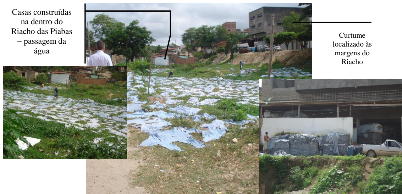
Foto 09 – Curtume às margens do Riacho das Piabas e casas construídas na passagem da água Fonte: Da Autora, 2013
