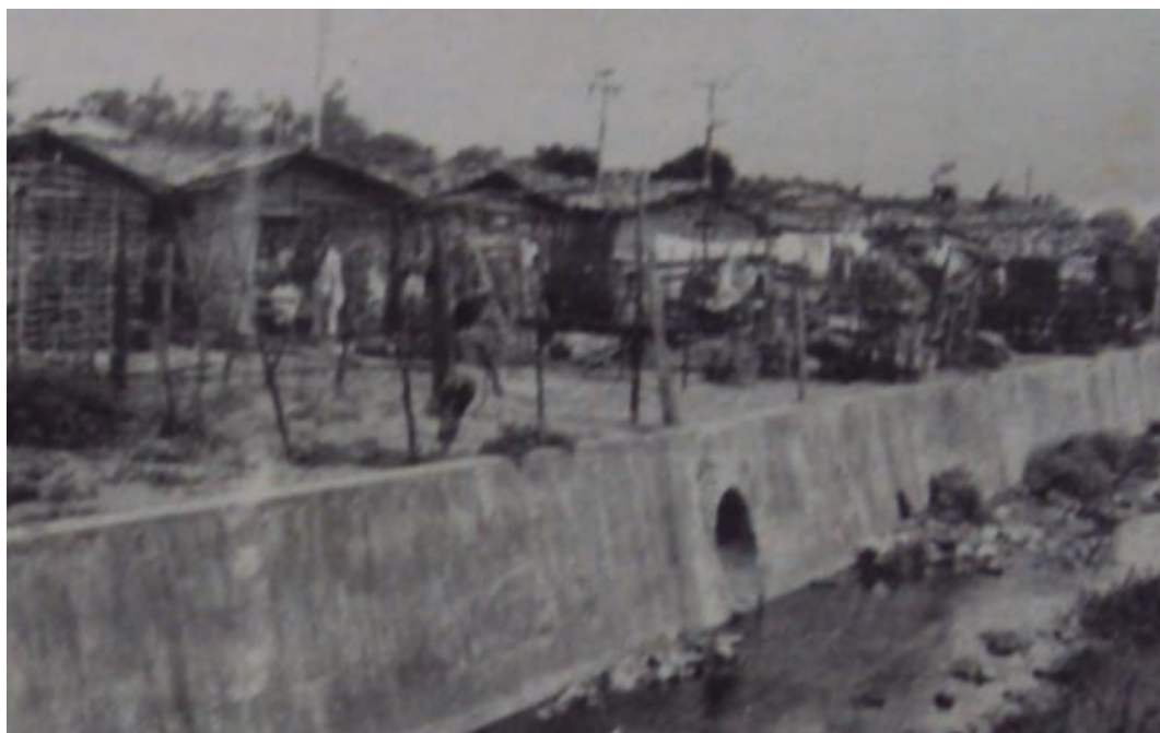
Figura 16: Imagem ocupação irregular no bairro Estação Velha em 1987.
