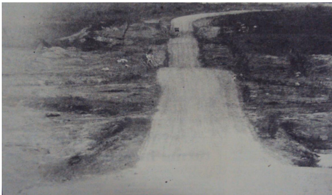
Figura 23: Construção da rodovia Alça Sudoeste em 1990. Fonte: Jornal da Paraíba, 28 de janeiro de 1990.
